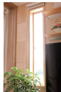
1F、2Fとも「縦すべり」の窓を設置。表側に開く窓が外の風をとらえ、室内に呼び込む通風設計。
